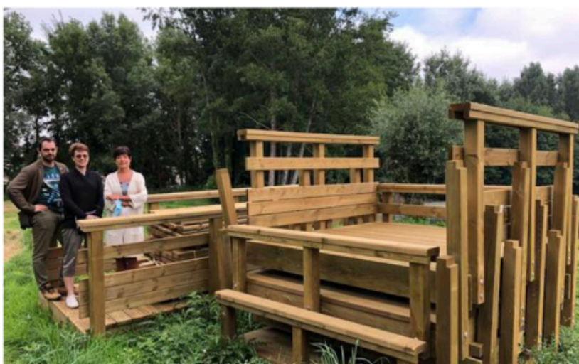
Le maire Jonathan Sanglard avec Marie-Paule Amiable et Isabelle Cailly, ses première et deuxième adjointes, sur la passerelle qui restait à monter sur l'étang et à côté des quatre pontons qui serviront aux pêcheurs.
