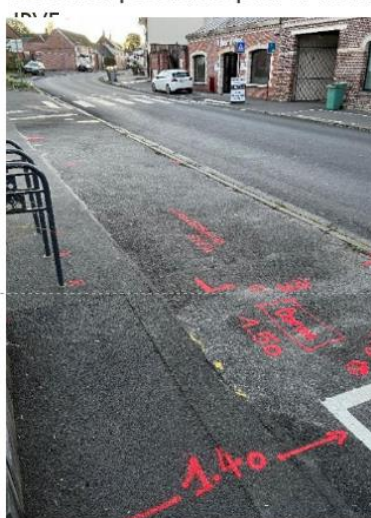
implantation de la Borne IRVE Emprise d'1,5 m entre deux places de stationnement Pose d'un potelet de part et d'autre de la Borne
